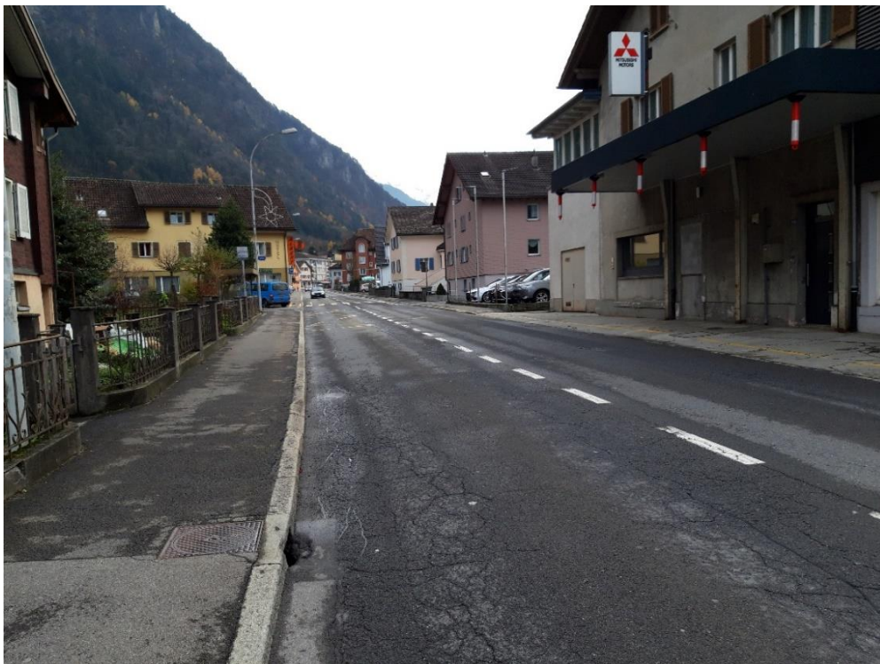
Bildlegende: Am 13. Januar 2020 starten die Bauarbeiten auf der Gotthardstrasse in Erstfeld.
